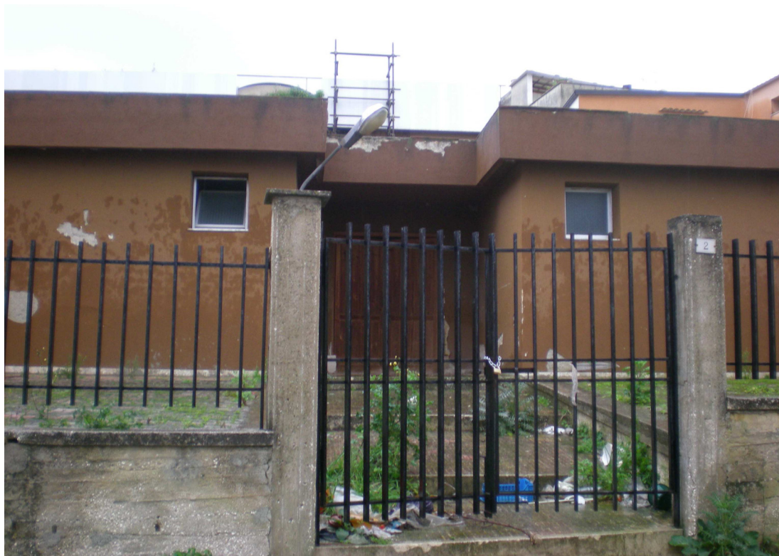
Fig. 1 – Prospetto principale blocco servizi
