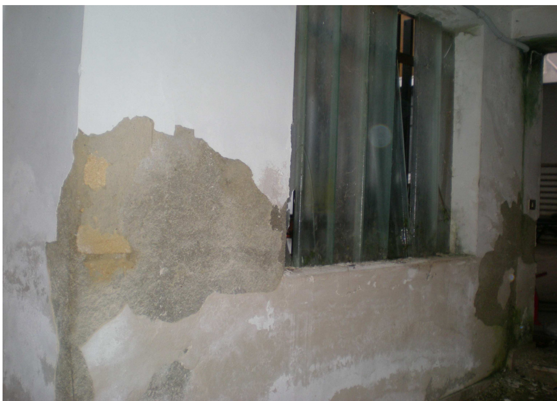
Fig. 10 – Corridoio di collegamento del blocco servizi e blocco palestra
