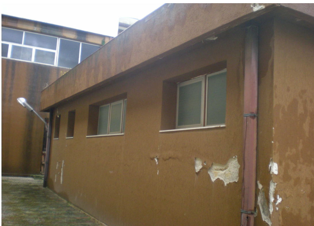
Fig. 4 - Vista laterale blocco servizi
